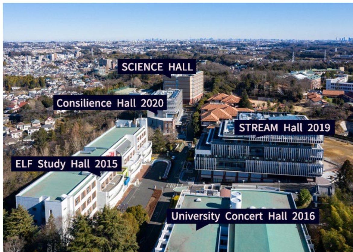
<写真 41> ESTEAM エリアの完成
