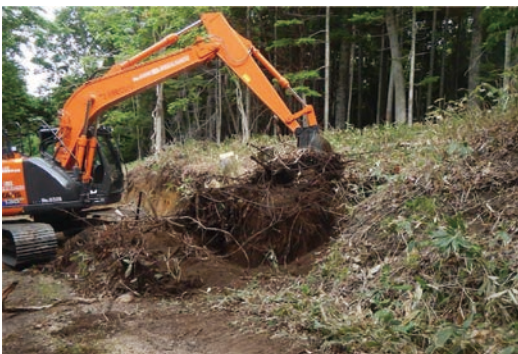
林道の掘削拡張（間伐作業に向けた重機搬入のため）
