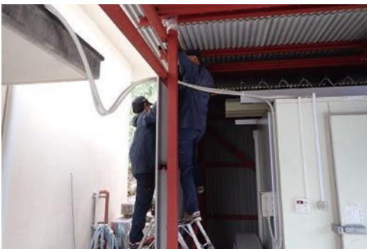
イノシシ解体設備の制作
