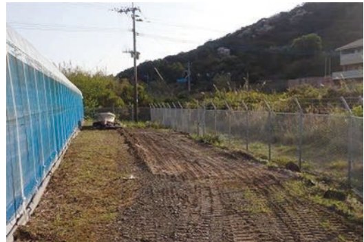
気象測定装置設置予定地に客土し整地
