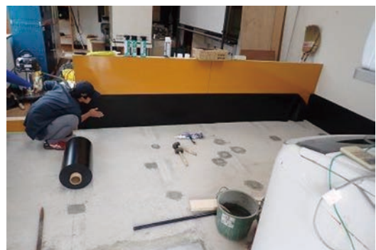
実験室の内装工事
