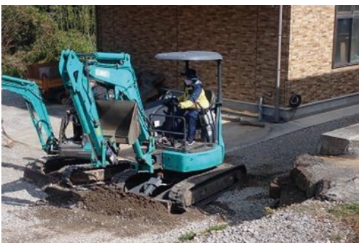
倉庫周りの道路整備
