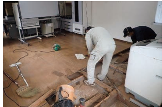
実験室の改装工事 (床板撤去)
