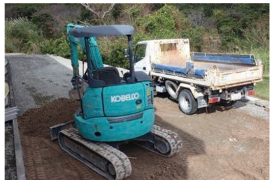
倉庫周りの未舗装道路の整備
