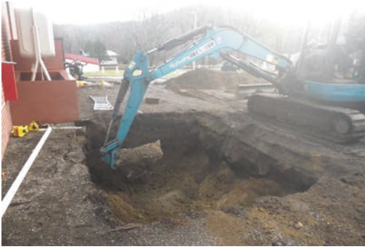
非常用発電機設置工事
