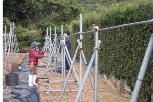
旧パッションフルーツ棚の撤去作業
