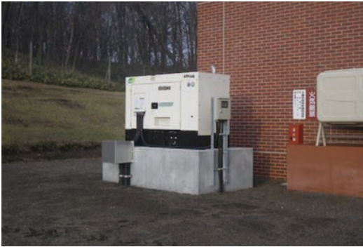
発電機設置作業完了
