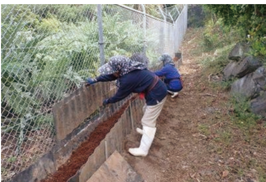
マンゴーハウス周りフェンスの補修
