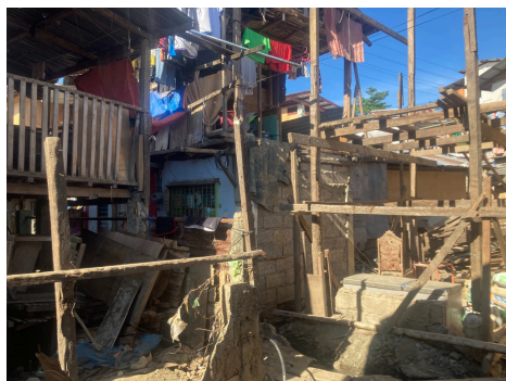
この写真は、被災地の民家の様子を写したものです。いくつかの家はひどく壊れており、骨組みだけが残っているのがわかります。私は、人生で初めてこのような状況を目の当たりにし、大きなショックを受けました。
