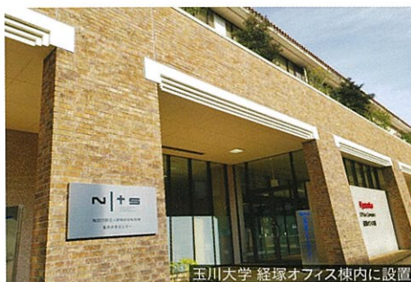
玉川大学 経塚オフィス棟内に設置
