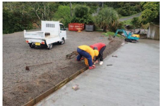
晴耕塾北側、道路脇の浸食対策、排水溝の設置
