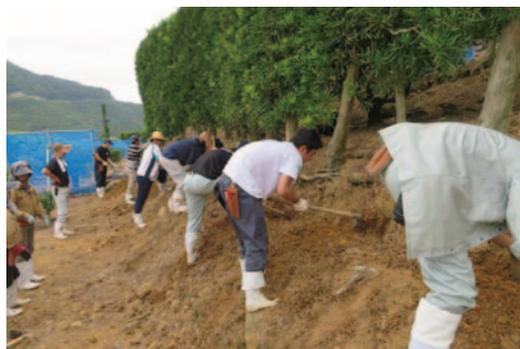
崩れた石垣の修復作業（土嚢を積む）
