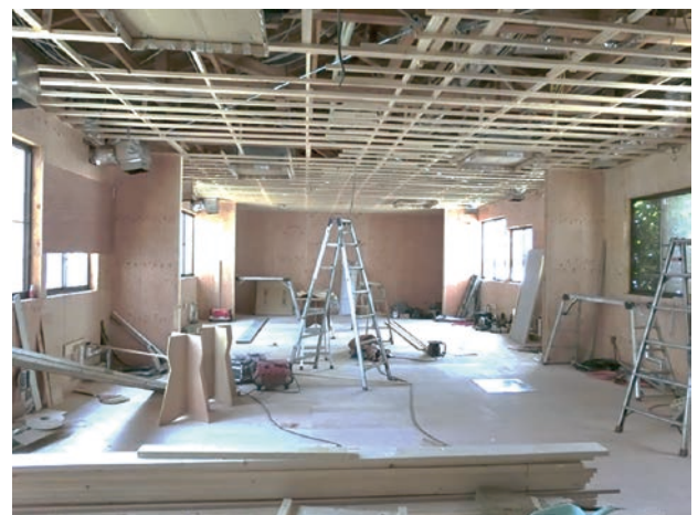
間仕切りを全て撤去、補強工事も施された
