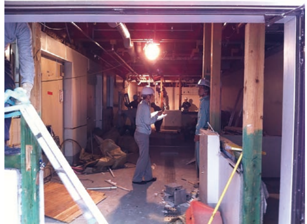
地階の畜産加工室の解体、壁を抜いて1室に改造
