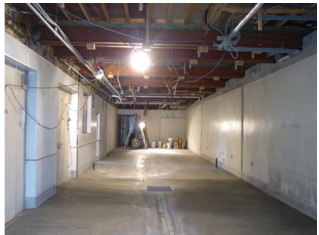
地階クリーンルーム化の下地工完了
