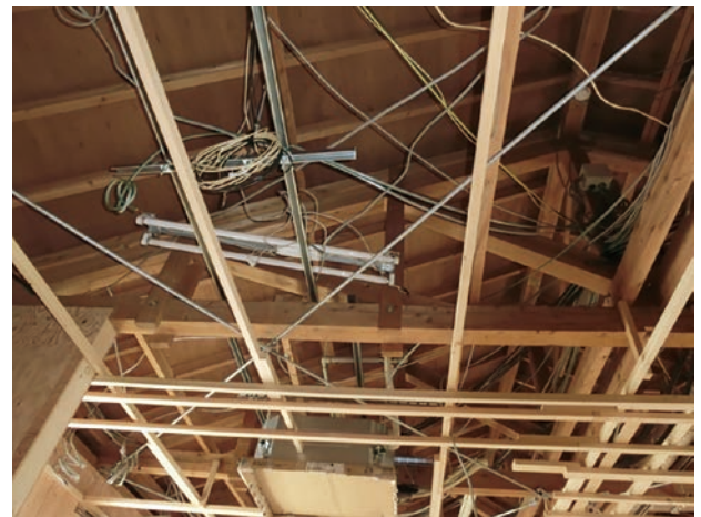
解体工事が始まり、天井部も全てスケルトンに
