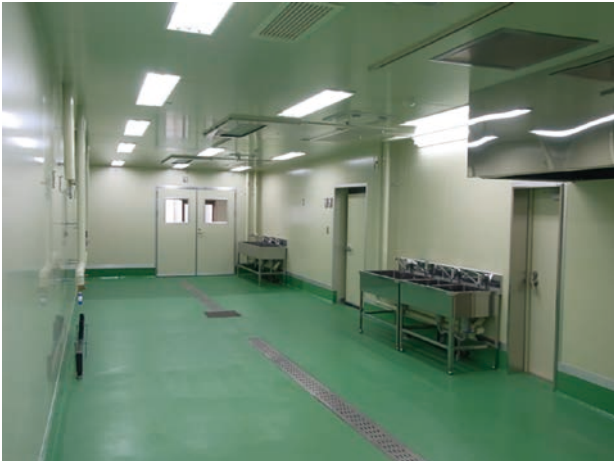
クリーンルーム完成 (2011.10.1)
