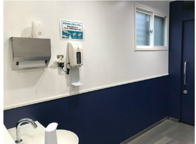
ドア開閉時の衝突防止対策、水滴飛散防止のためペーパータオル仕様、洗剤、アルコール自動噴霧器
