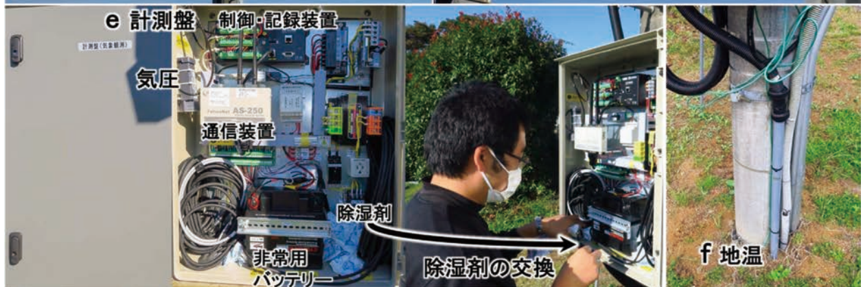
図2 玉川大学学内農場の気象観測装置 (2019年9月～)
